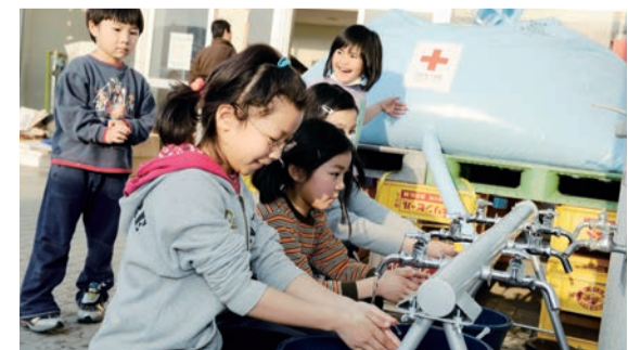
東日本大震災では行政による対応が追いつかず、日赤が避難所に簡易水道を設置した例も
